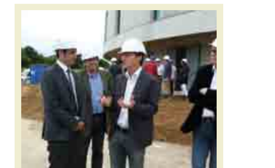
Visite de chantier en présence de Djoudé Mérabet, président du Conseil de Surveillance (CHI), Gérard Snyers, directeur technique et hôtelier (CHI), Benoît Hue, ingénieur travaux (CHI) et Patrick Le Moëme, architecte (Ataub).
