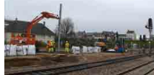
Pour l'électrification de la ligne, le pont routier enjambant les voies de chemin de fer doit être rehaussé de 50 cm.
