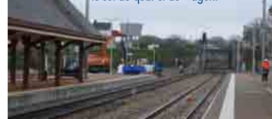
Les quais de la gare sont rehaussés de 50 cm, pour assurer le prolongement entre le sol du quai et du wagon.
