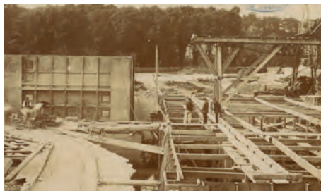
La construction des écluses de Saint-Aubin,
